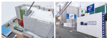
仮設計画イメージベース 工事状況
